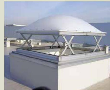
採光と同時に換気、また万が一の場合に対応する優れた耐火性能をもった「EFP」。アルミ押出型材の外枠とステンレス材の内枠を組み合わせることで、耐火補強を実現しました。遮音性に優れた遮音タイプ (受注生産) も用意しています。
